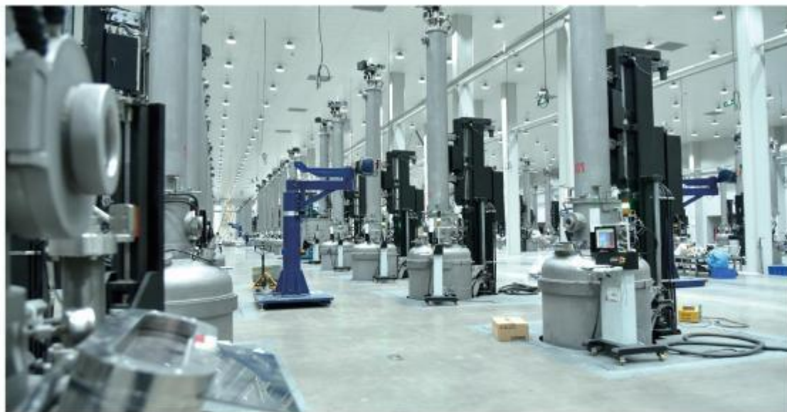
包头晶澳太阳能科技有限公司晶澳3吉瓦单晶拉晶、铸锭、切片项目生产车间
