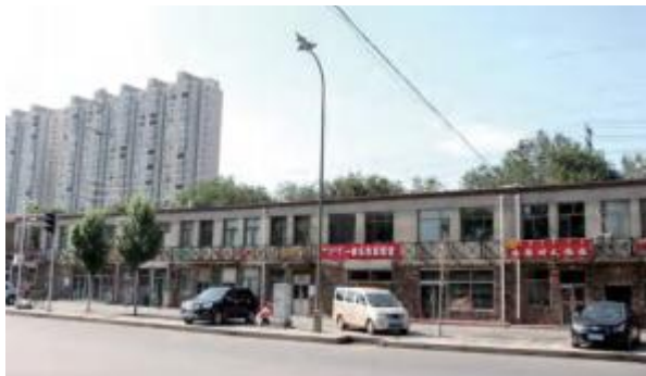
包头二电厂对面底店（改造前）
